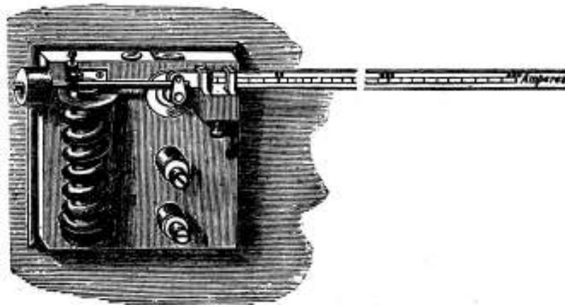
Fig. 12. STEEL YARD AMMETER.
