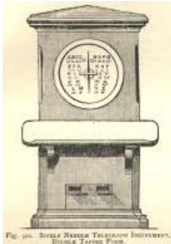
Fig. 322. SINGLE NEEDLE TELEGRAPH INSTRUMENT, DOUBLE TAPPER FORM.
